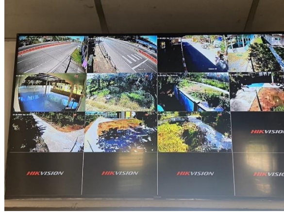
ติดตั้งกล้องวงจรปิด
